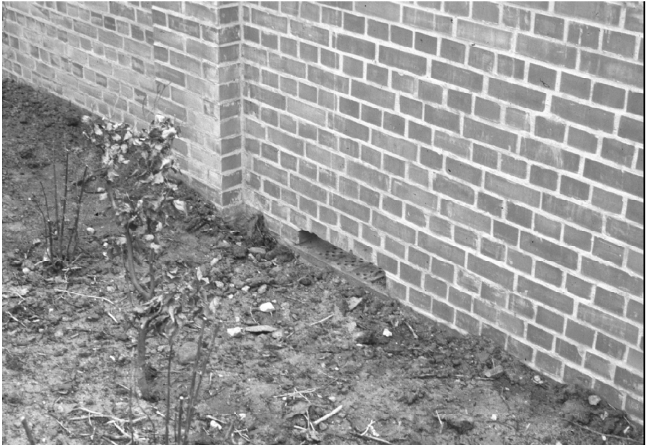
Abb. 4: Amphibiendurchlass an der Begrenzungsmauer des St. Theodosius-Krankenhauses. Opening in the wall of St. Theodosius-Hospital to allow amphibian migration.
